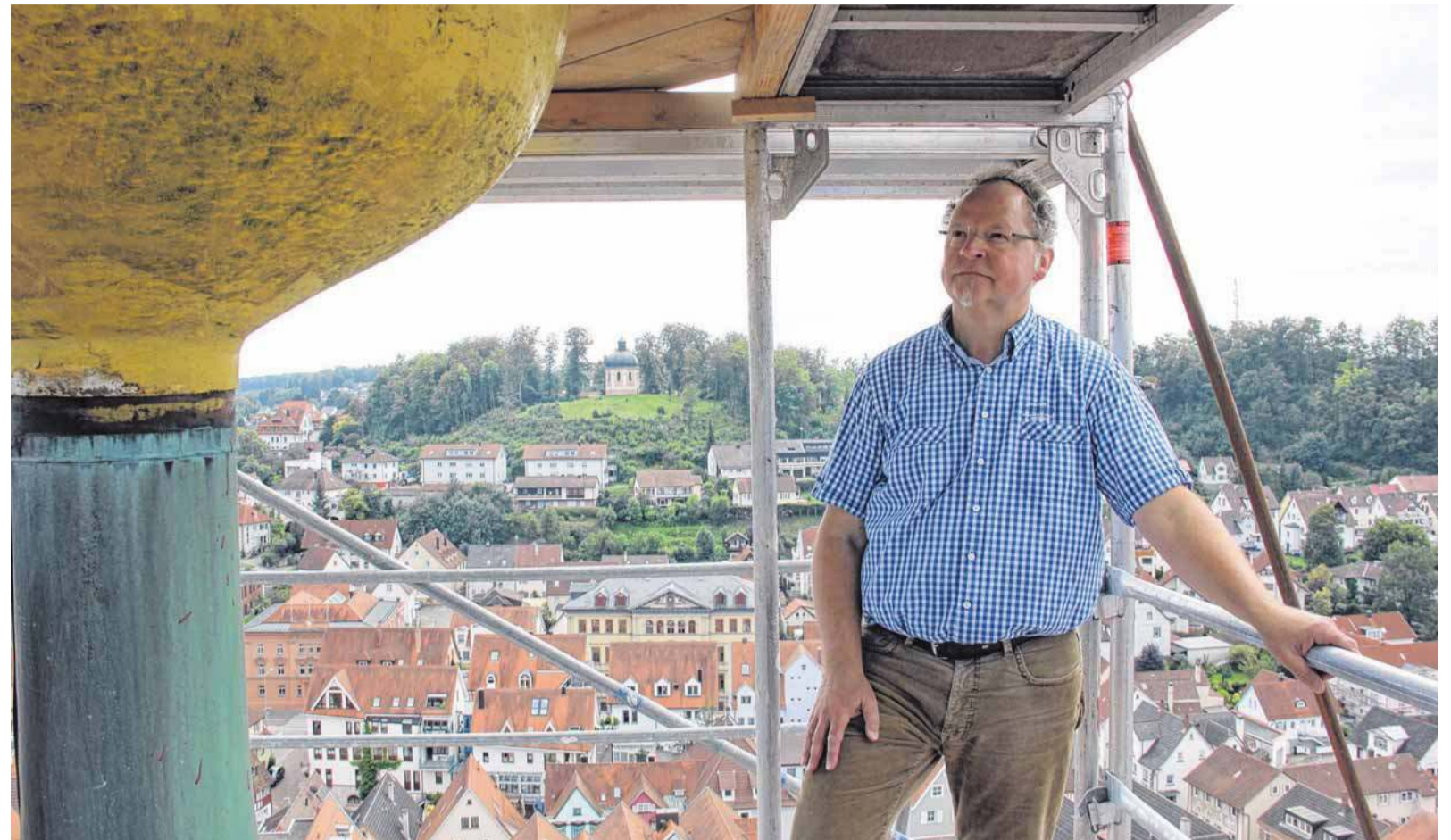
Der Architekt Uwe Frank macht sich täglich ein Bild von der Arbeiten auf der Baustelle.
